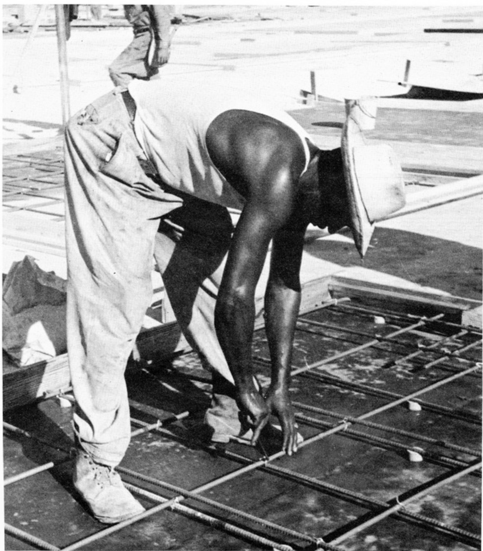
Techos y paredes de hormigón son reforzados con cabillas para darles más consistencia.
